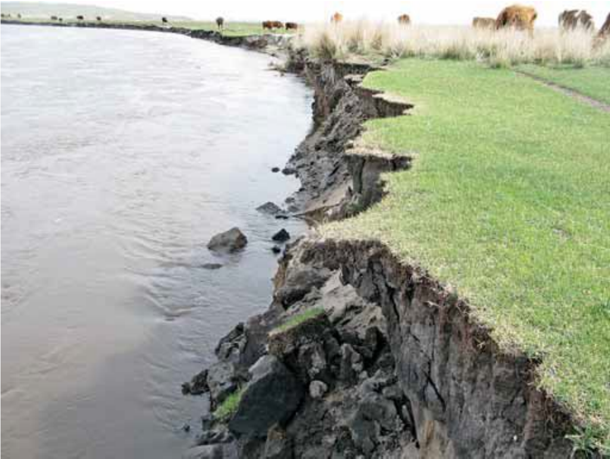
Fig. 6. Riverbank erosion on the Kharaa.
